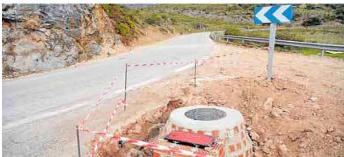
Instalación de uno de los nuevos hidrantes en el acceso a Cartajima. SUR
